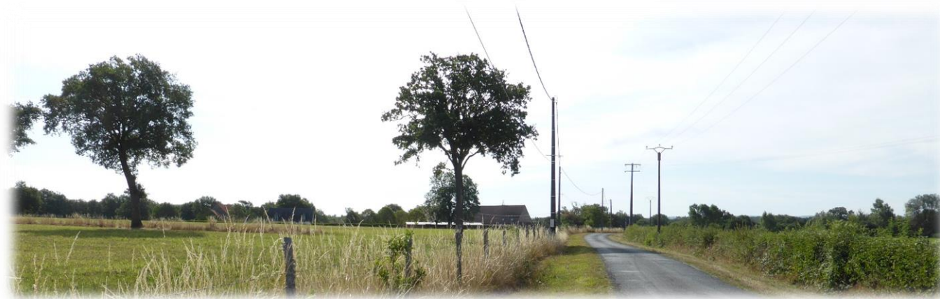
Réseaux aériens le long de la voie communale menant à Montgrenier (© ECTARE)
