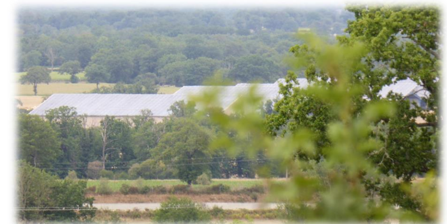
Bâtiments photovoltaïques du château de Périgord
